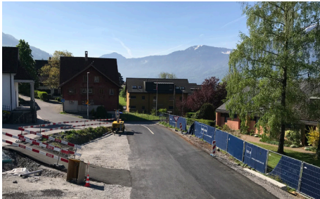
Provisorischer Anschluss an die Vorderbergstrasse
