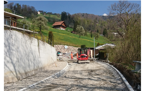
Strasse nach Einbau von Randsteinen und Fundamentalschicht
