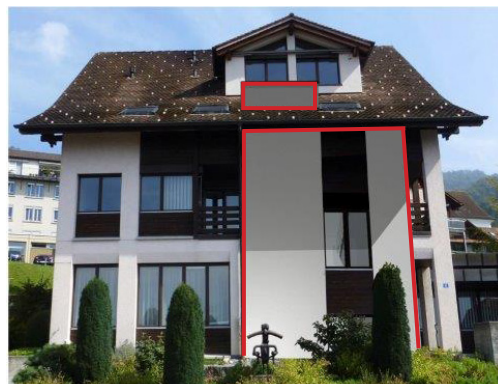
Neues Treppenhaus und Liftanlage
